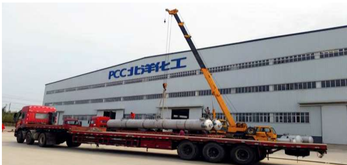
Shangdong Kunda Pyridine Нефтеперерабатывающий завод \Phi 1300 * 48000 мм
